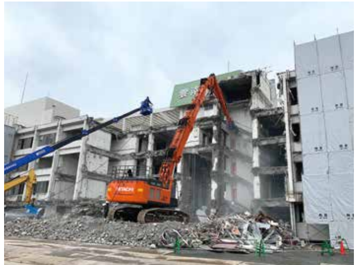
病院西棟（昭和42年に雲南共存病院本館として建設）解体工事
