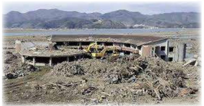
被災した大川小学校
