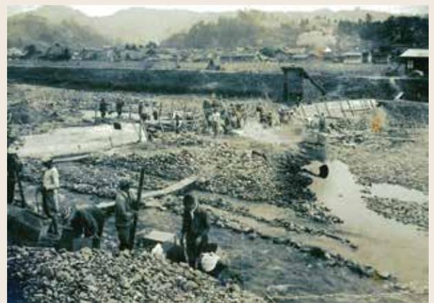
昭和10年頃の写真だと思います。赤川に架かる勝田橋上流にある荊屋垣堰(かりやがきぜき)の修復工事写真です。
