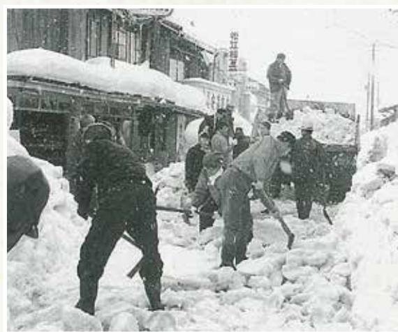
連担地の除雪作業(西本町)
