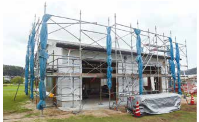
「現在建設中の倉庫棟」
